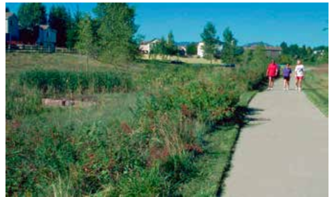
Figure 5.11 Exemple de canal du réseau majeur intégré à un aménagement de piste cyclable.
