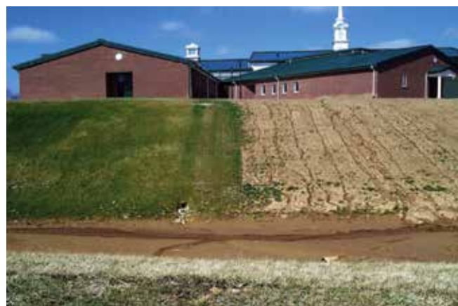
Figure 8.16 Exemple de sol remanié non protégé.
