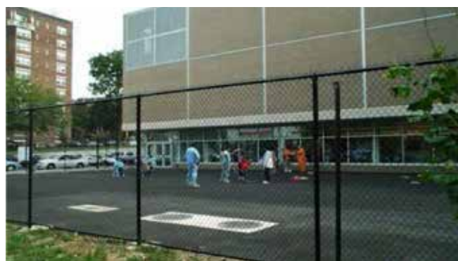
Figure 11.44 Aménagement d'une cour d'école avec un revêtement poreux.
