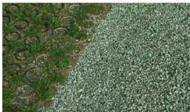
Figure 11.42 Système de pelouse renforcée (GVSD, 2005).
