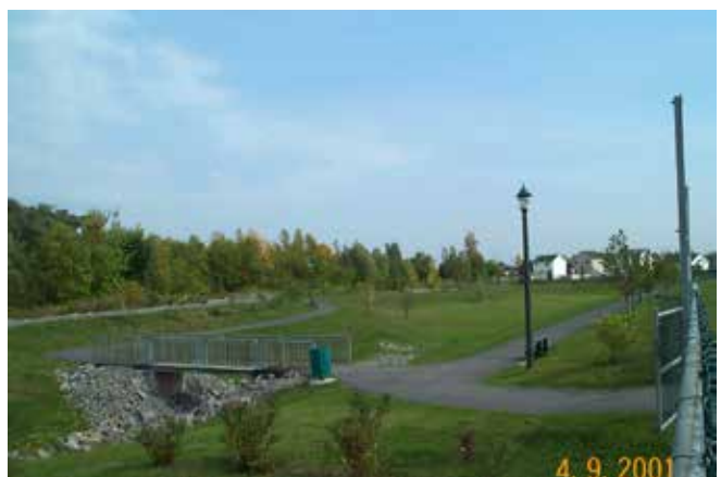
Figure 11.8 Exemple de bassin avec clôture. Le bassin inclut des aires de promenade mais l'accès y est interdit en cas de pluie (cadenas à la clôture).
