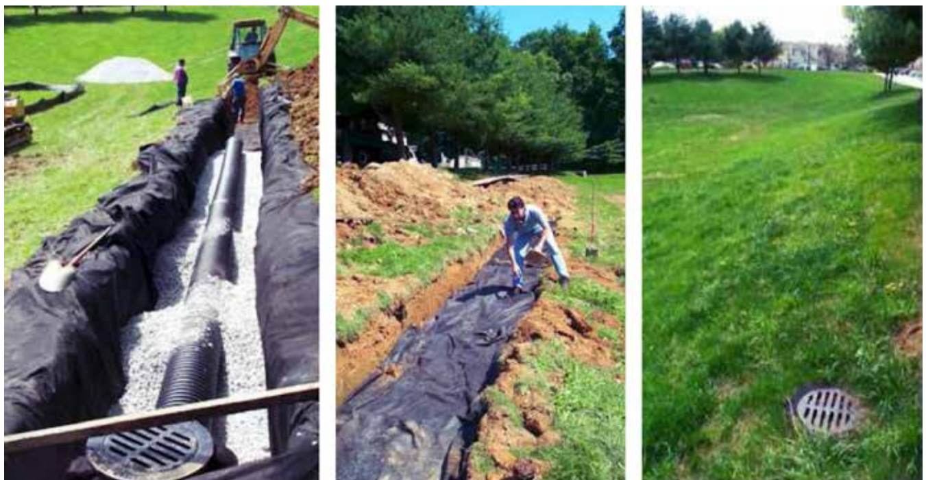
Figure 11.61 Installation d'un système avec conduites perforées.
