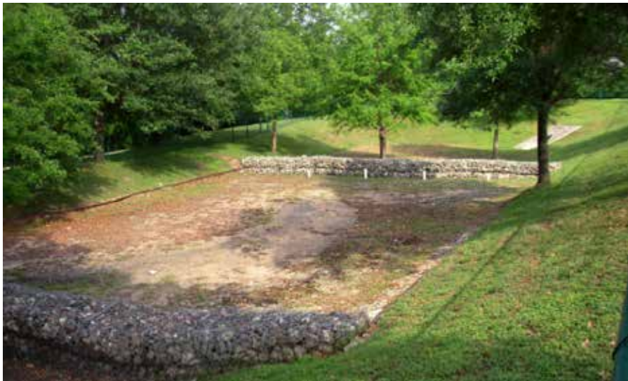
Figure 11.89 Aménagement d'un filtre à sable de surface.
