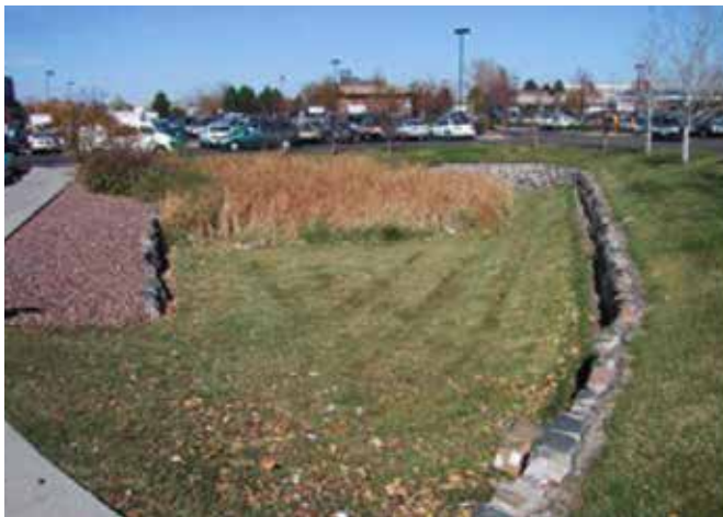
e. Utilisation de murs verticaux à limiter lorsque possible.
