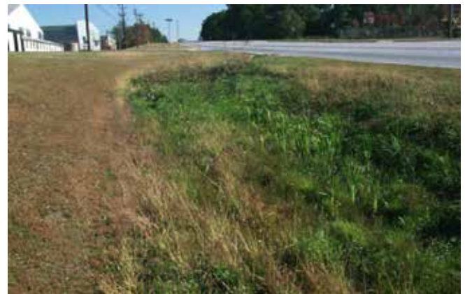
Figure 11.55 Exemple d'aménagement de noue avec retenue permanente.
