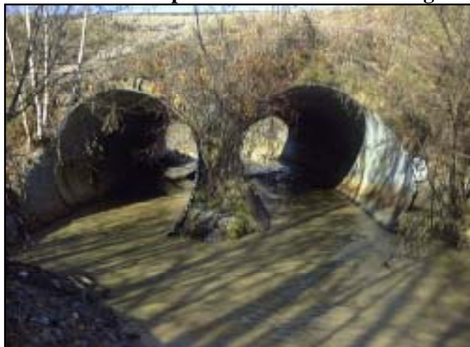
Figure 2.1 Vue des deux ponceaux du ruisseau Rouge
