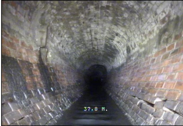
Figure 4-2. Collecteur ovoïde 1 800 mm sur 1 200 mm en brique construit à Montréal en 1865
