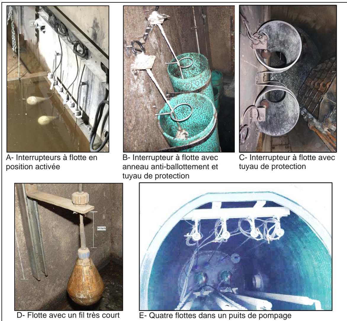
Figure 6-7. Différentes installations d'interrupteurs à flotte
