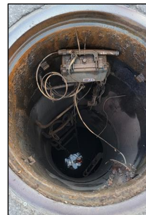
Figure 6-3. Système de suivi électronique des débordements
