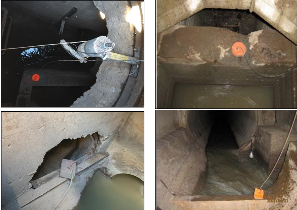
Figure 6-1. Exemples de repères visuels installés à un ouvrage de surverse
