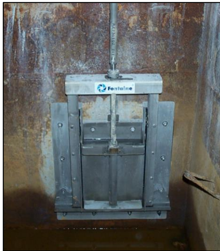
Figure 5-4. Exemple de vanne murale avec trop-plein de type déversoir
