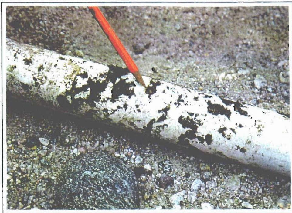
↑ La présence de solides non dégradables au niveau des orifices de distribution dans l'élément épurateur n° 6
