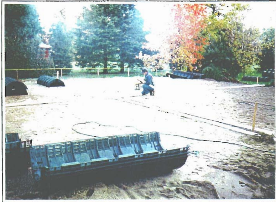
↑ L'installation des conduites de distribution principales (CDP)
