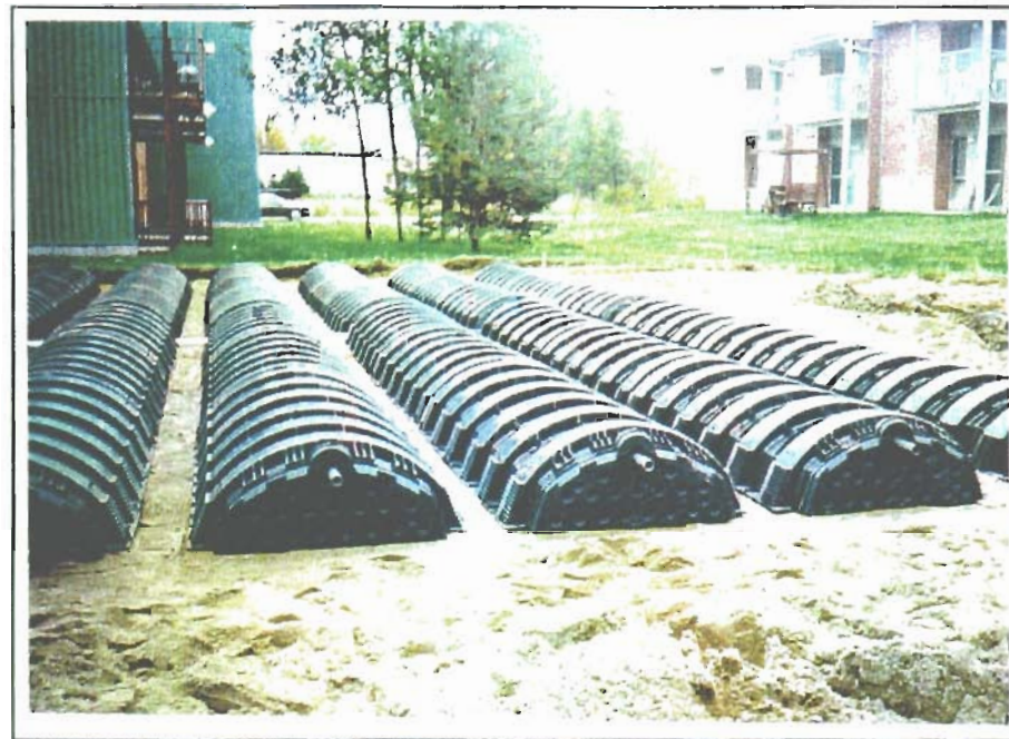
↑ L'installation des chambres d'infiltration sur le milieu filtrant (pas de gravier)
