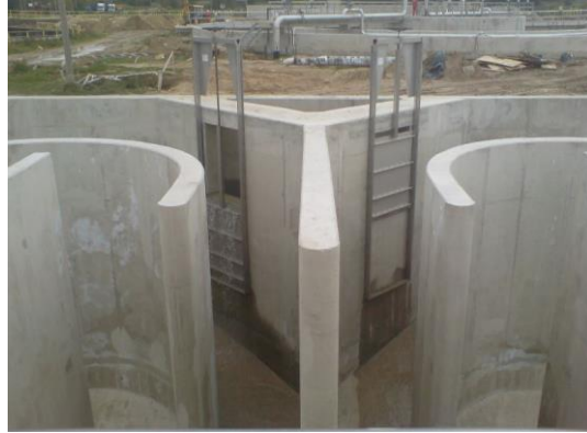
Figure 4.4.6-1 – Exemple d’une répartition en T profilée
