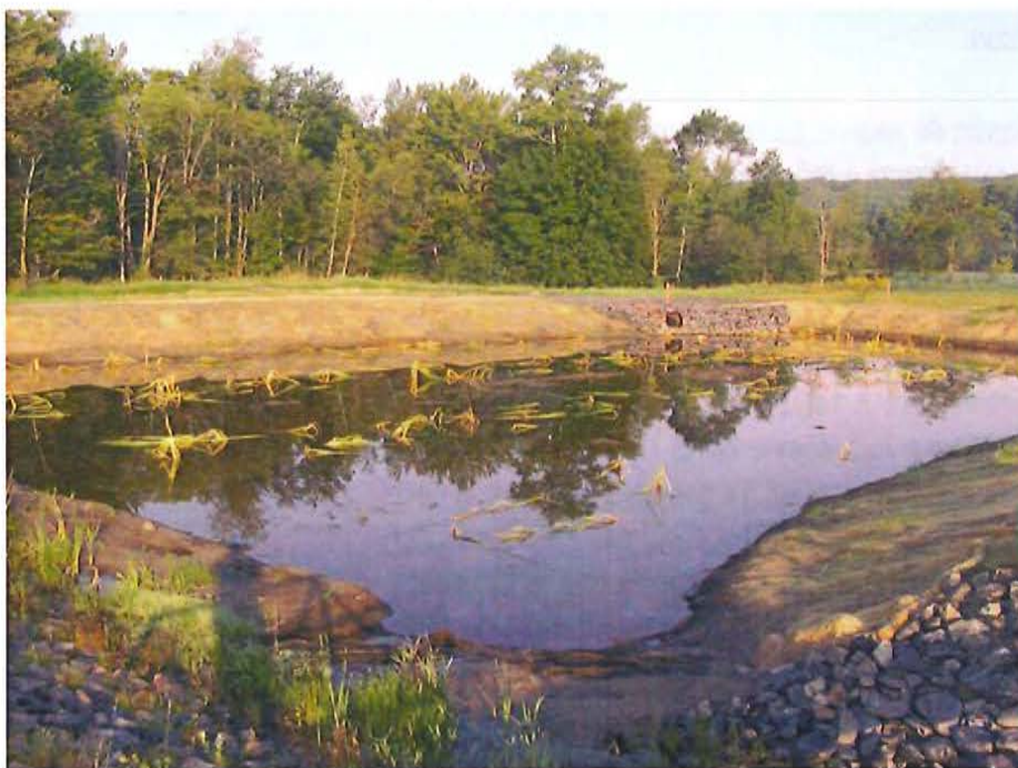
Figure 4 - Marais filtrant du Centre communautaire (3 septembre 2010)
