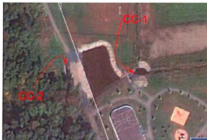
Figure 2 – Bassin de sédimentation et marais filtrant (Photo Google)
