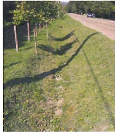
Photo 8 : Chemin Tibbits Hill – Fossé côté gauche
