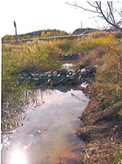
Photo 2a Seuil sans drain
